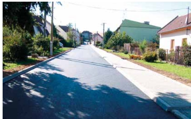
Rekonstrukce vozovky na Novém světě
