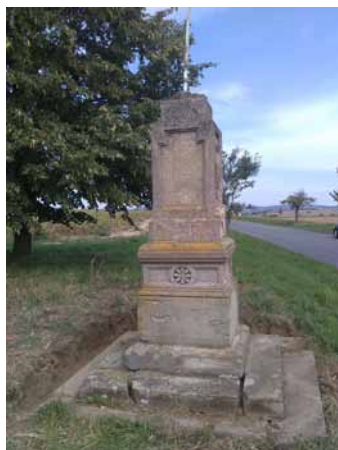
Před rekonstrukcí v roce 2015
