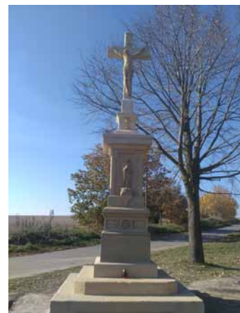
Po rekonstrukci v roce 2015
