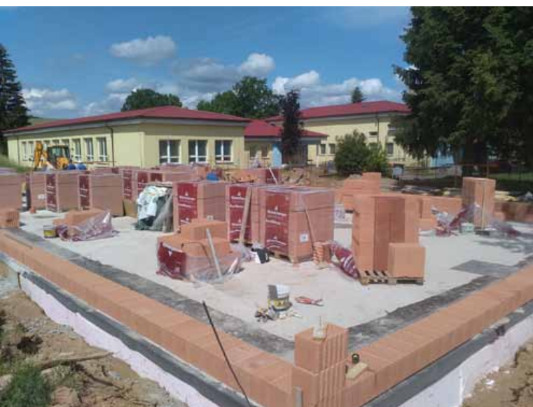
Práce na nové stavbě základní školy
