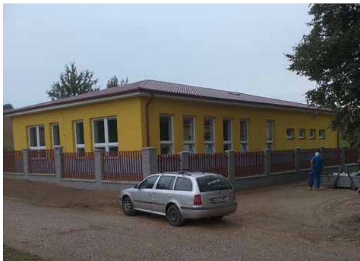
29. 8. 2016 proběhlo předání stavby nové základní školy
