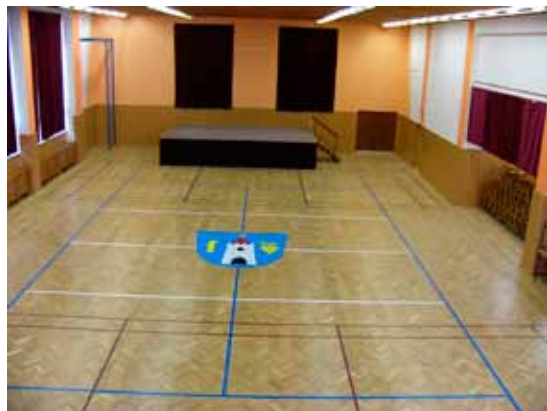
Oprava sálu v kulturním domě
